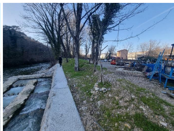
Slika 5: Pogled proti severozahodu, levo ureditev ribje steze
