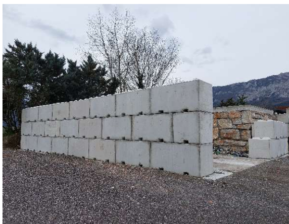
Dobavljeni betonski bloki
