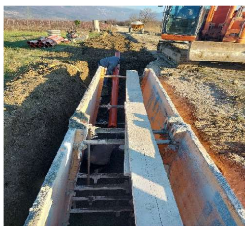
Izgradnja kanalizacije Lože – Manče
