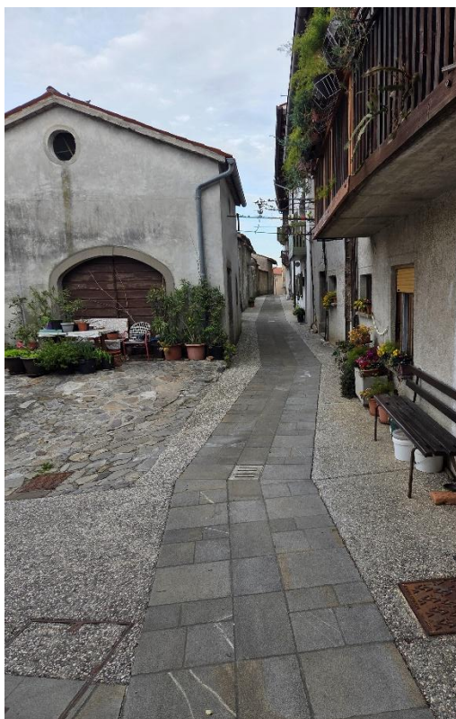
Urejena odvodnja meteorne kanalizacije z manipulativnih površin
