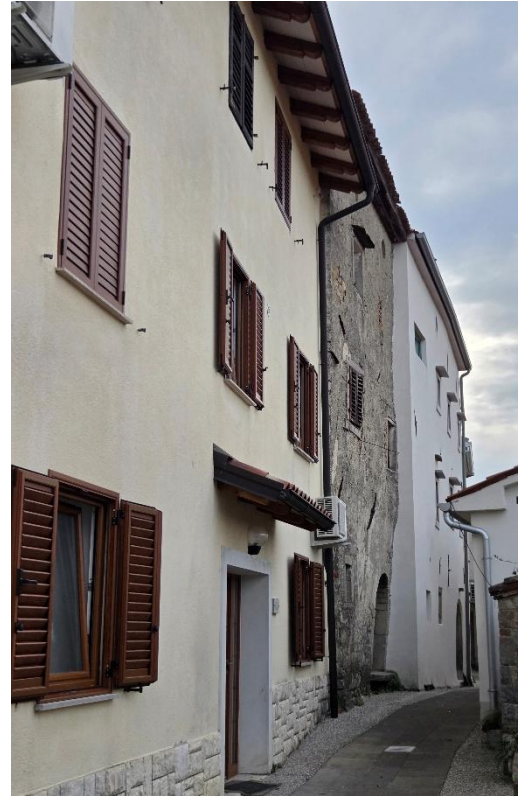
Ravne stene starih in novih hiš kot znak stabilne gradnje in temeljenja
