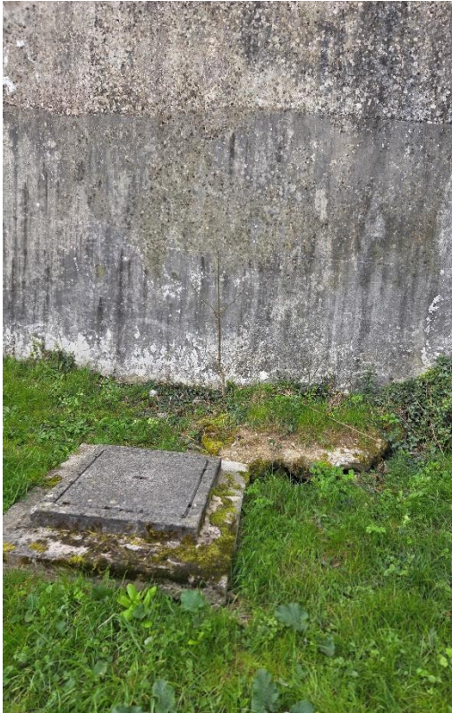
Posedanje tal v severovzhodnem delu OPPN. Smatramo, da je pod pokrovom ponikovalnica.
