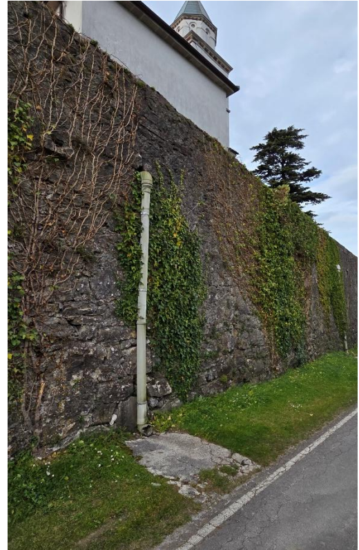
Odvod meteorne vode razpršeno na cesto v severnem delu OPPN
