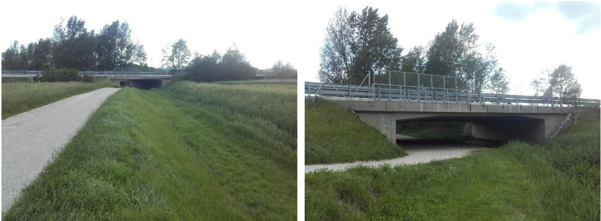
Slika 8, 9: Struga in most čez Kožmanski potok na hitri cesti H4
