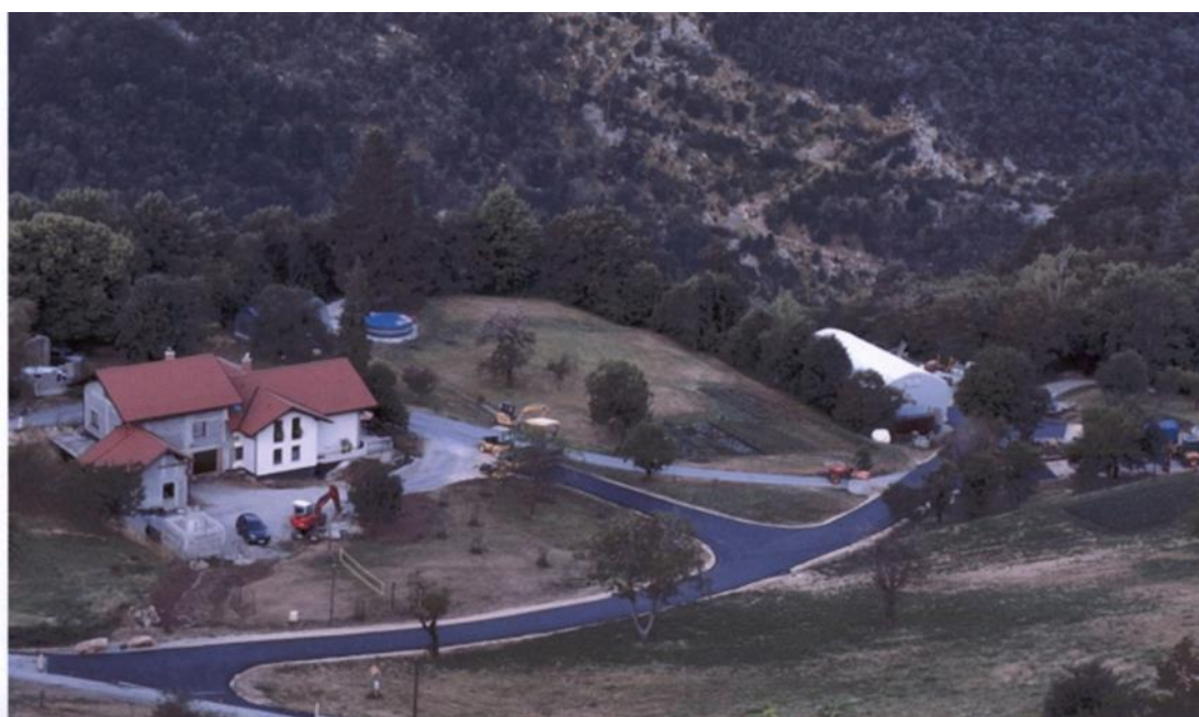
Prikaz nove ceste po parc. št. 422/2 k.o. Višnje, severno glede na objekt, pogled V-Z
