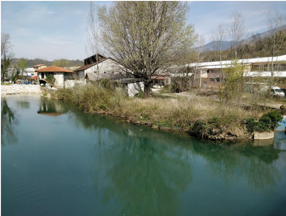
Slika 5: Pogled iz cestnega mostu dolvodno na skrajno gorvodno lokacijo predvidenih podpornih AB zidov. Na sliki je viden vtok v mlinščico (desno) in obstoječi zidan visokovodni zid (levo). Fotografirano na terenskem ogledu območja posega dne 07. 04. 2023.
