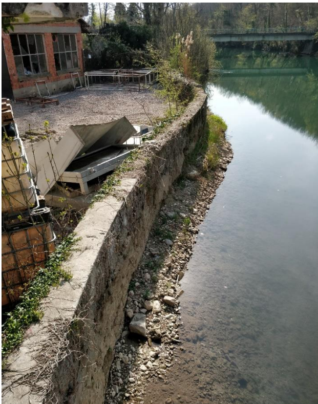
Slika 6: Obstoječi betonski protipoplavni zid gorvodno od jezua. Fotografirano na terenskem ogledu območja posega dne 07. 04. 2023.
