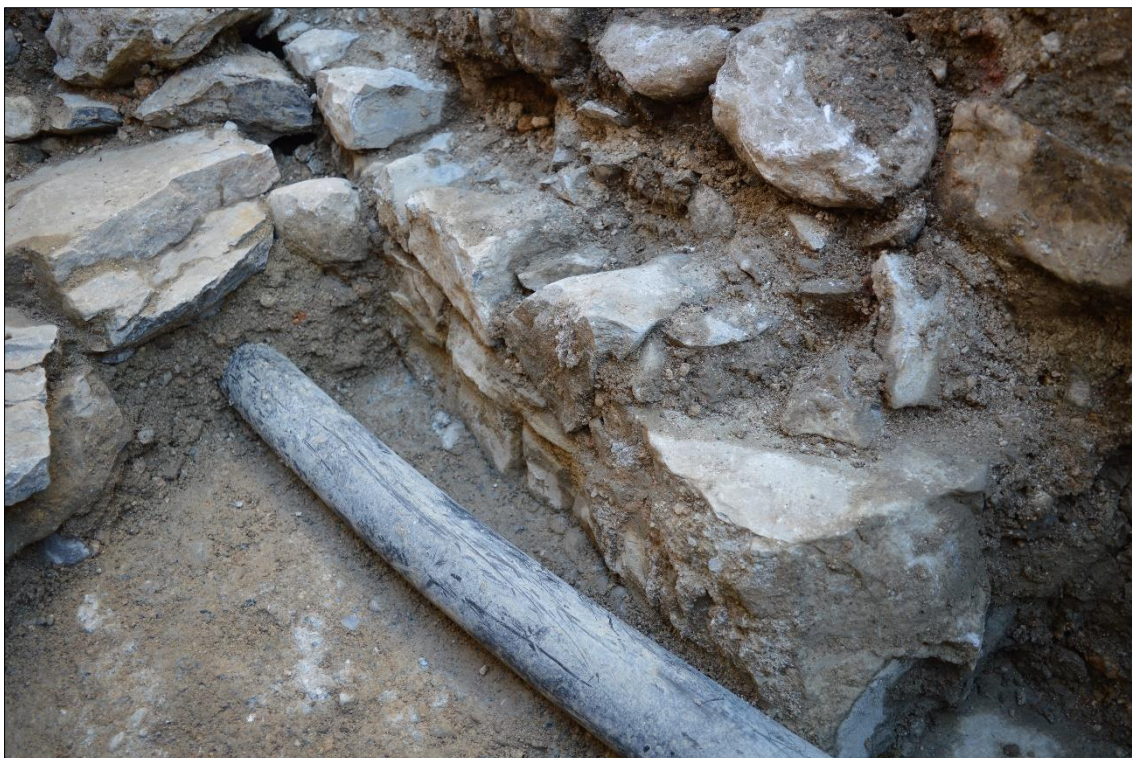
Slika 39: Pogled na poškodovan zid SE 005 (foto: U. Košir, 2016).
