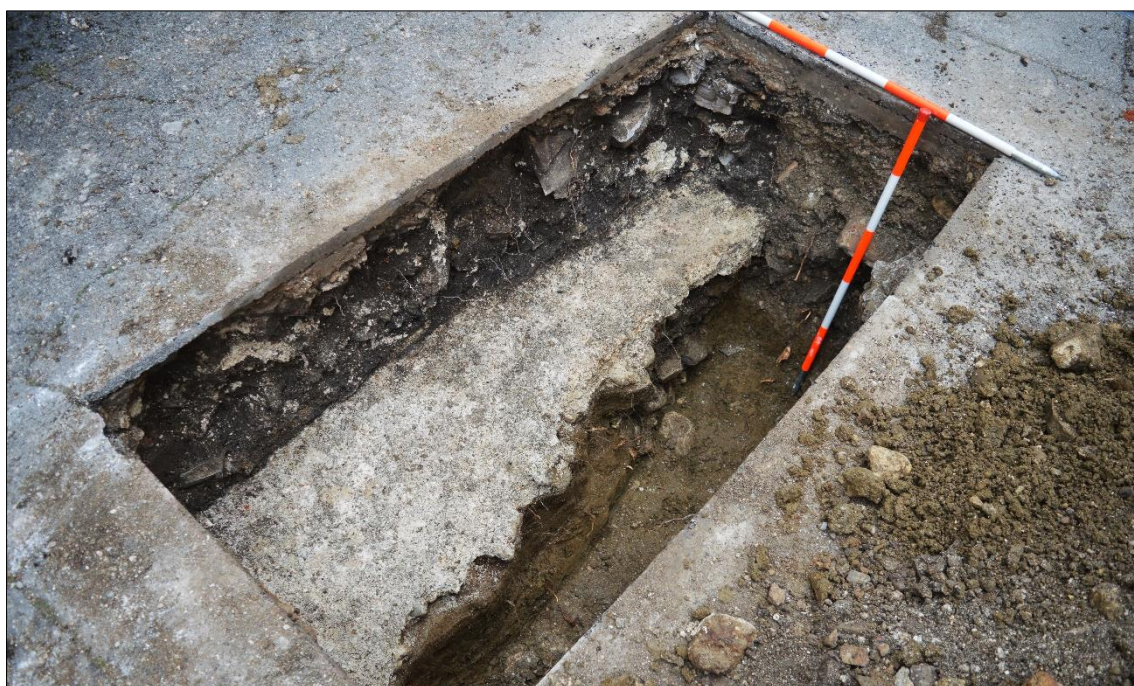
Slika 42: Pogled na poškodovano utrjeno površino SE 008 (foto: U. Košir, 2016).
