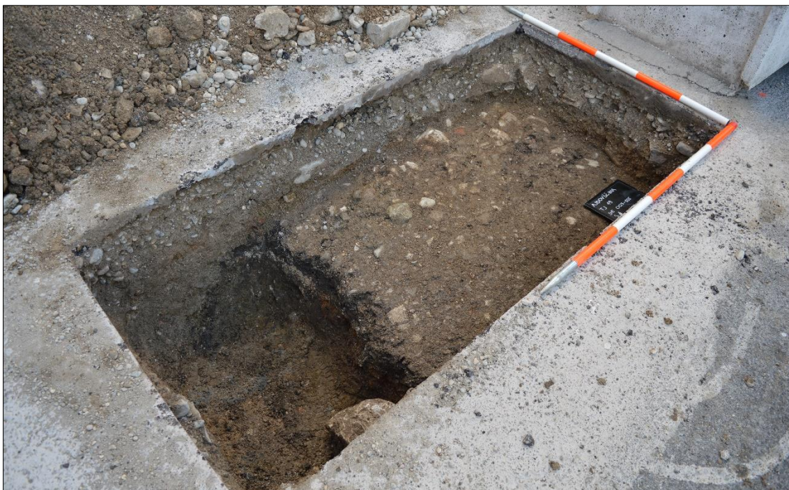
Slika 68: Z recentnim vkopom poškodovana hodna površina SE 005, pogled proti severovzhodu (foto: U. Košir, 2016).
