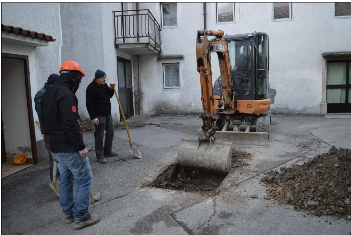
Slika 8: Strojno odstranjevanje plasti je potekalo pod stalnim nadzorom arheologa (foto: U. Košir, 2016).
