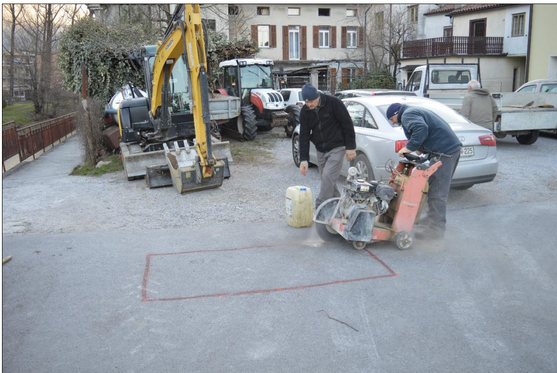
Slika 6: Rezanje površine z motorno žago za asfalt in primer označene lokacije testnega jarka (foto: U. Košir, 2016).
