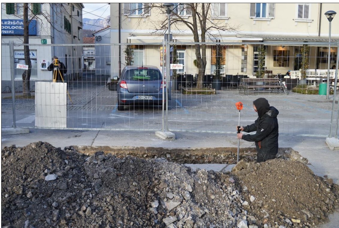
Slika 10: Posamezne zidane ostaline so bile dokumentirane tudi z elektronskim tahimetrom (foto: U. Košir, 2016).
