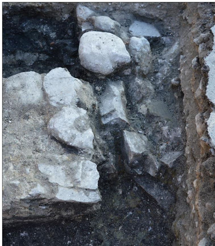
Slika 148: Pogled proti jugu na poškodovana zidova SE 007 in 008 (foto: U. Košir, 2017).
