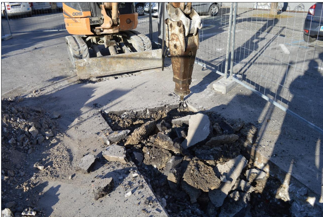
Slika 7: Odstranjevanje asfalta s pomočjo hidravličnega kladiva (foto: U. Košir, 2017).
