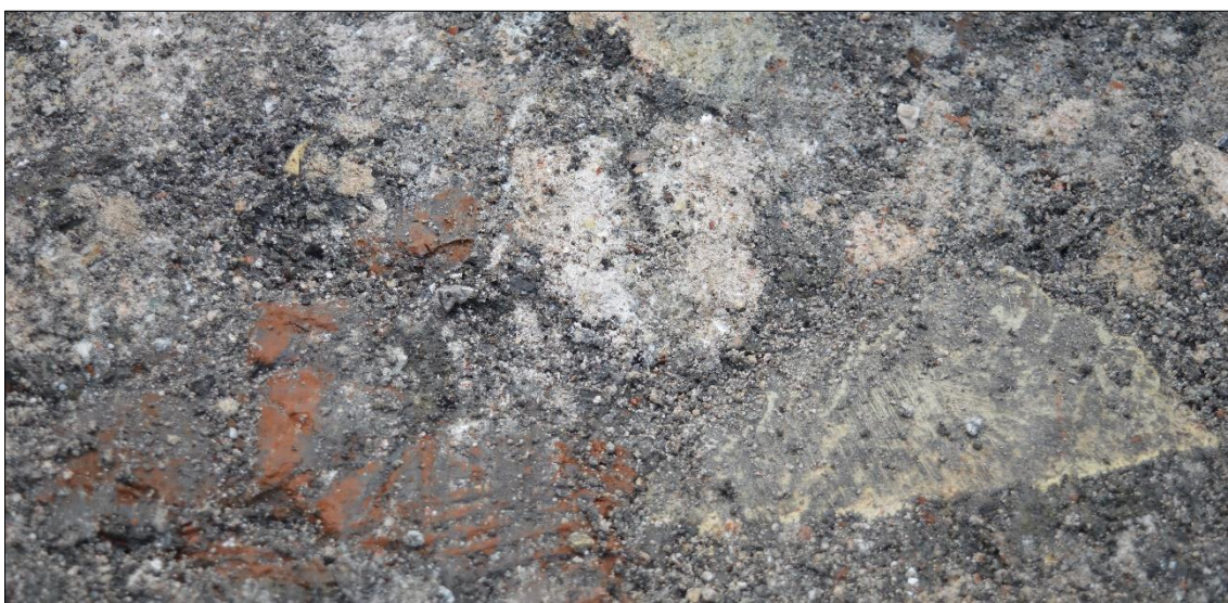
Slika 98: Detajl hodne površine s kosi tegul in tubulov (foto: U. Košir, 2017).
