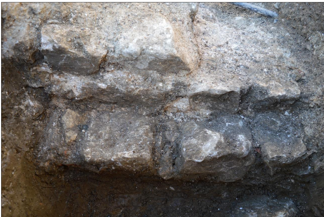
Slika 59: detajl južnega lica zidu in temelja (foto: U. Košir, 2016).
