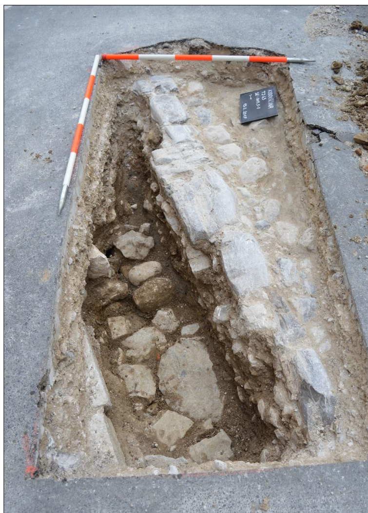
Slika 160: Z vkopom poškodovana tlakovana cesta. Pogled proti jugu (foto: U. Košir, 2017).
