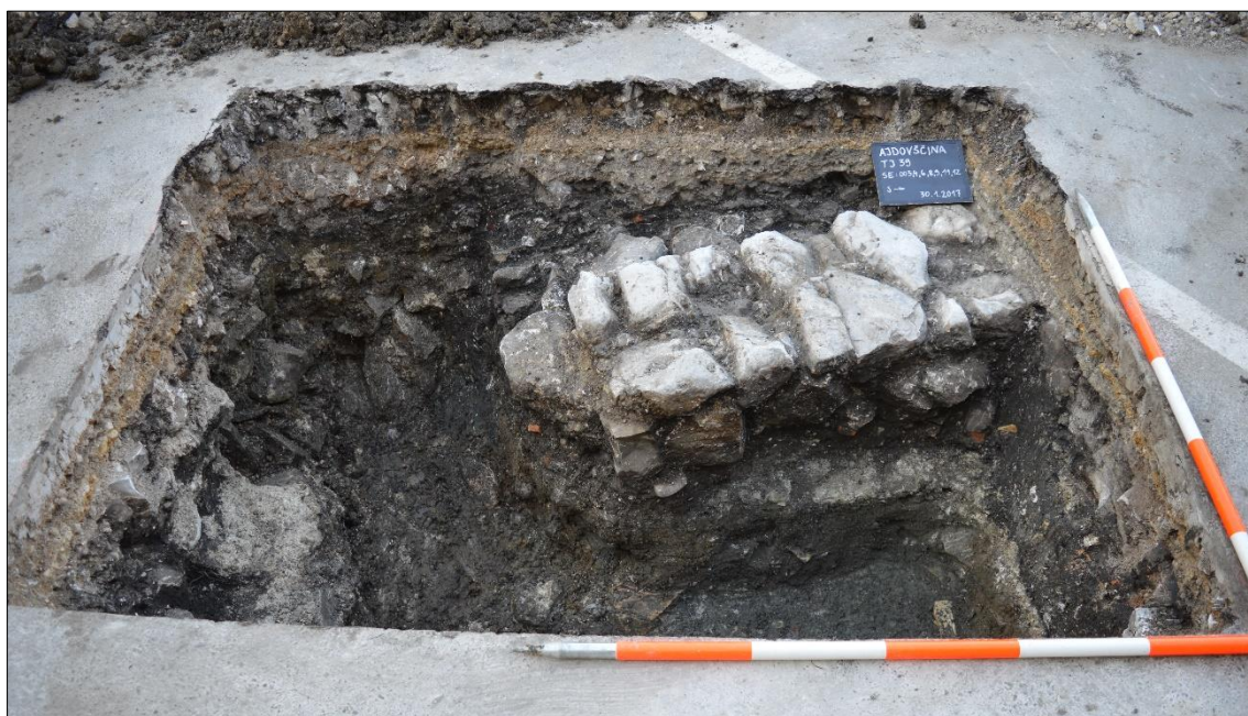
Slika 136: Pogled proti zahodu na poškodovana zidova v TJ39 (foto: U. Košir, 2017).
