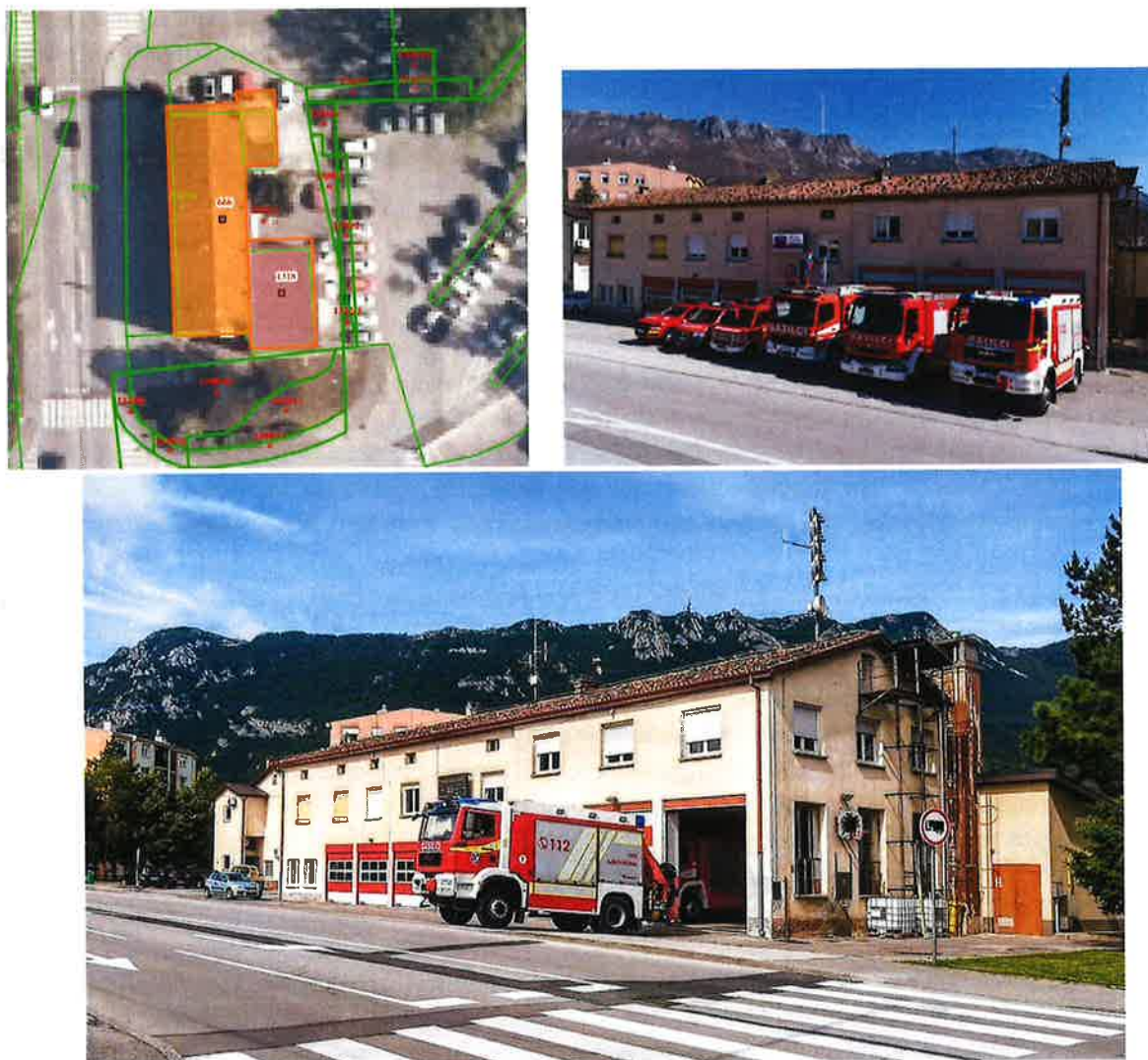
Slika 4: Obstoječa stavba GRC Ajdovščina na naslovu Tovarniška cesta 3h, 5270 Ajdovščina.
