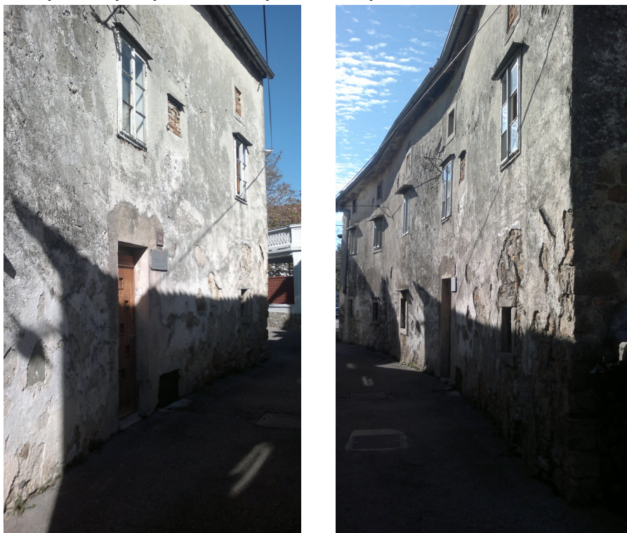
Slika 5: Obstoječe stanje objekta na Stritarjevi ulici 1a, Ajdovščina – 1. del.
