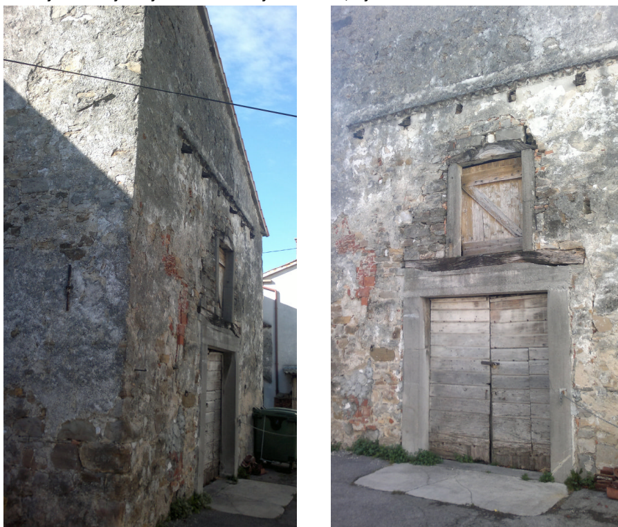
Slika 6: Obstoječe stanje objekta na Stritarjevi ulici 1a, Ajdovščina – 2. del.
