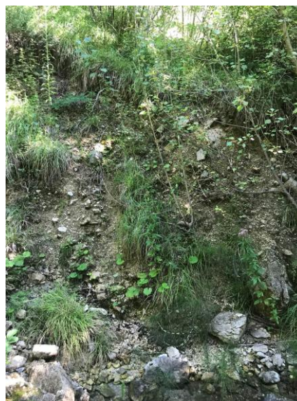
Slika 18: Erodirana leva brežina struge (skupno 3 odseki dolžine po ca 10 m)
