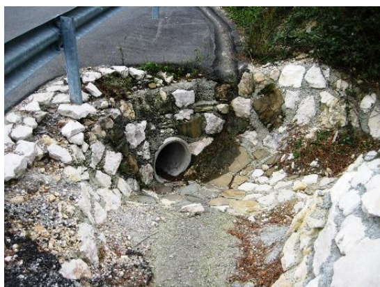
Slika 6 Vtok v prepust
