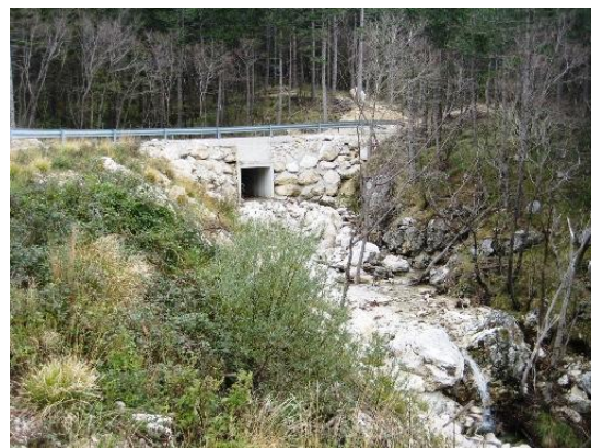
Slika 5 Škatlast prepust na prečkanju potoka Lokavšček
