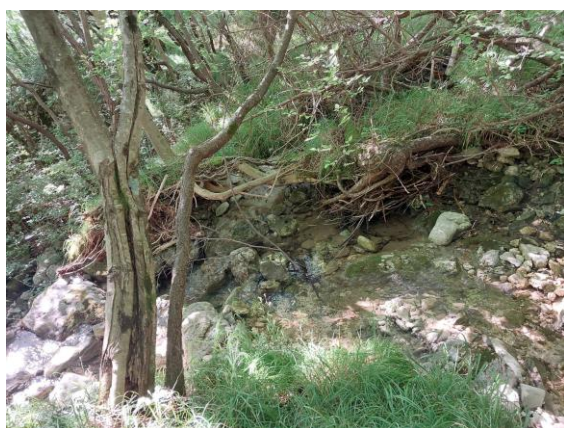
Slika 16: Brežina struge usekana v aluvialnem materialu
