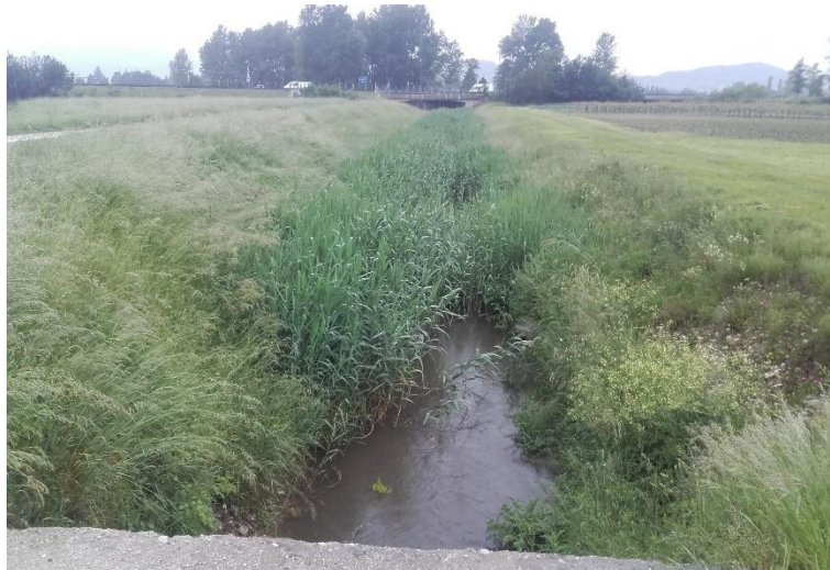
Slika 4: Pogled na strugo Kožmanskega potoka dolvodno od sotočja z odvodnikom A
