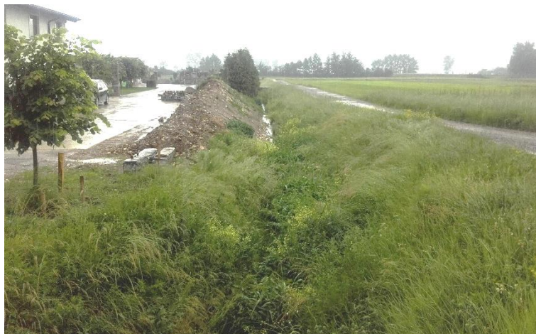
Slika 3: Pogled na strugo odvodnika A v območju profila S10 (na levem bregu izveden nasip)
