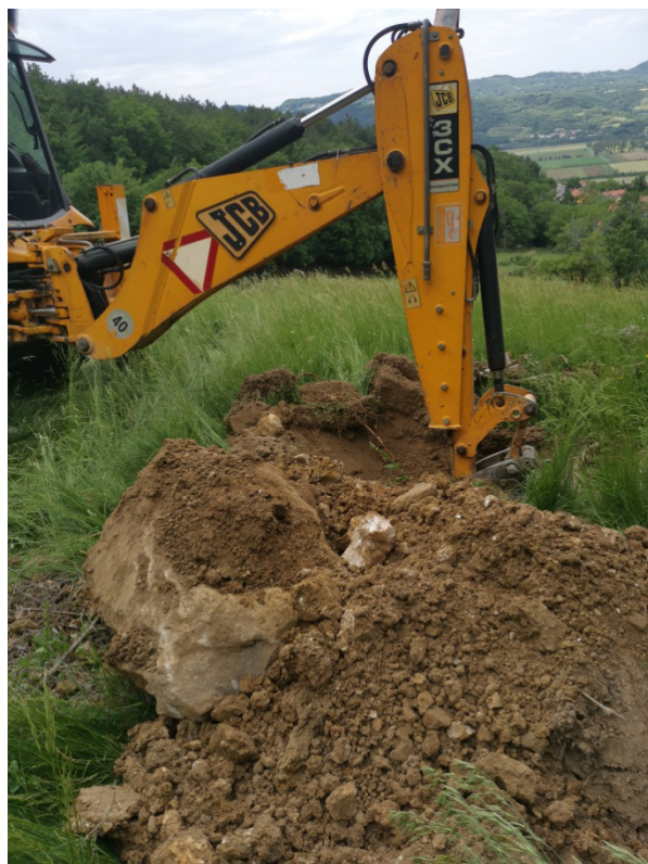
Slika 4: Izvedba razkopa R-2
