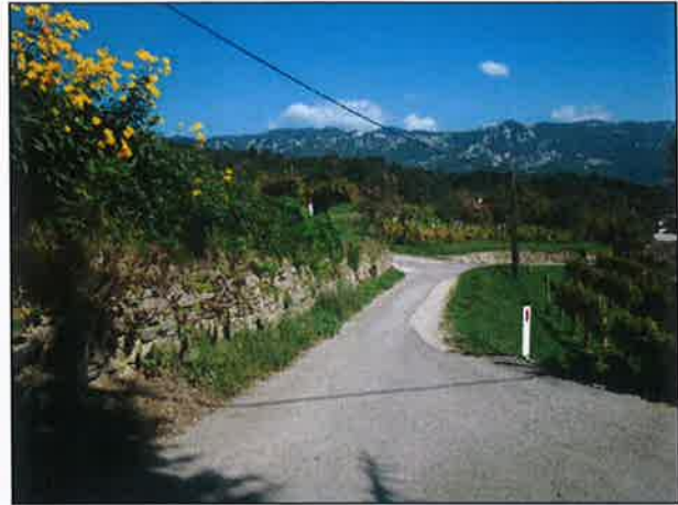
Potek vodovodne veje V2 in V5 po pogojno stabilnem delu pobočja med VJ2.5 in V2.54.
