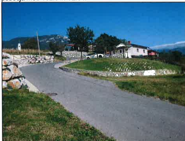
Vodovodna veja V5, pogojno stabilen do plazovit del pobočja stabiliziran z kamnitimi zložbami in pilotnimi stenami.
