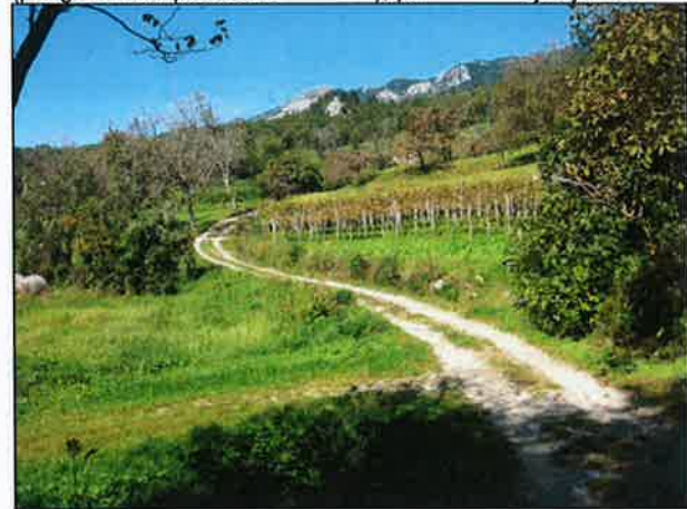
Potek vodovodne veje V3 po pogojno stabilnem delu pobočja med VJ3.7 in VJ3.4 (med zaselkoma Bratini in Černigoji).
