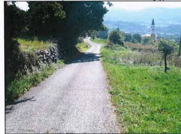
Potek vodovodne veje V3 po pogojno stabilnem delu pobočja med VJ3.2 in VJ3.1 (med zaselkom Černigoji in strnjenim delom vasi Stomaž), brežine podprte z zidovi, posecki na cesti.
