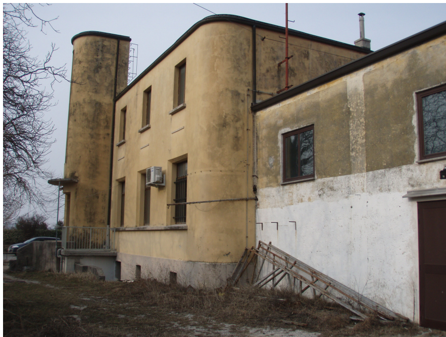
Slika: Obstoječi objekt bivše osnovne šole z prizidkom (pogled z južne strani)
