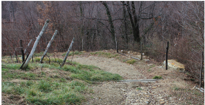
03 SLIKA Obračališče z urejeno odvodnjo
