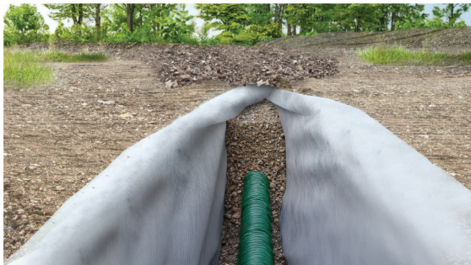
05 SHEMA Pravilna izgradnja drenažnega sistema
