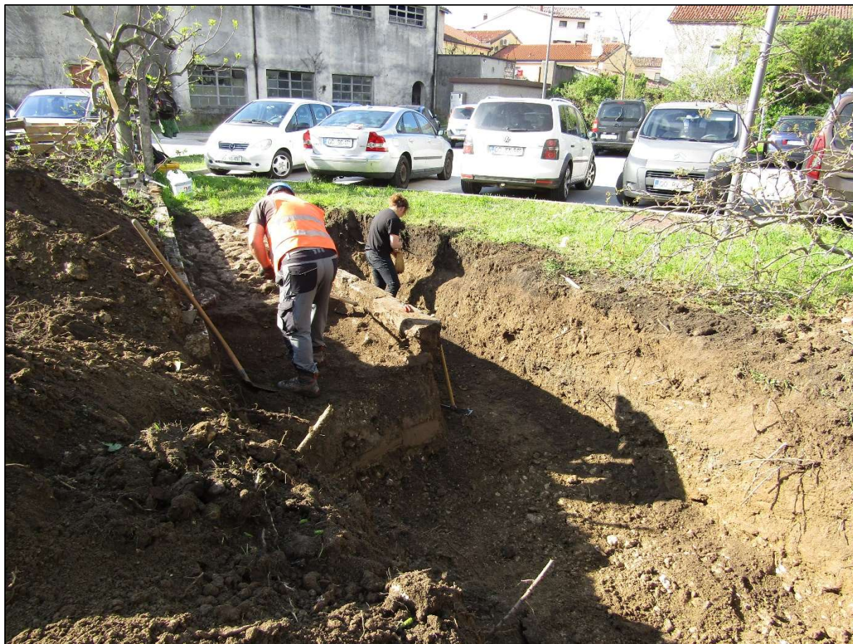
Slika 2: Ročno čiščenje testnega jarka (foto: G. Gruđen, 2024).
