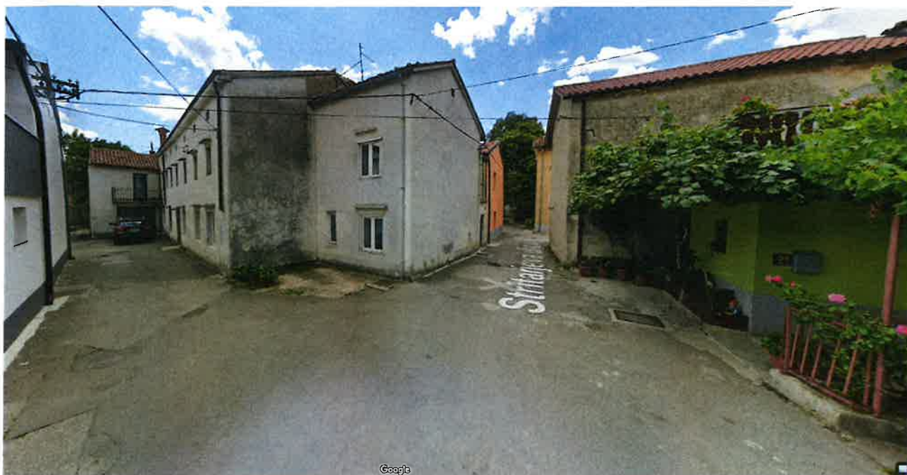
Slika 4-4: Primer obstoječega stanja (Vilharjeva – Stritarjeva ulica)
