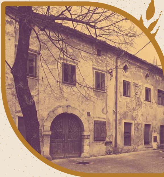
Rustjeva hiša pred obnovo
