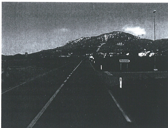
Slika 2: Pogled na priključek za naselje Kožmani v smeri Ajdovščine, pogled v smeri stacionaže.
