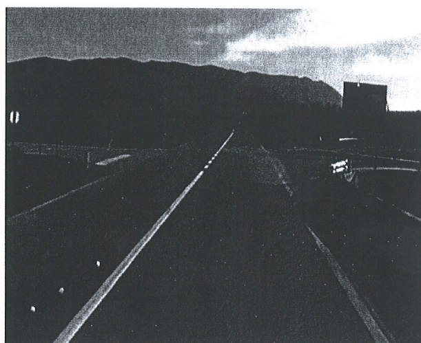
Slika 3: Pogled na priključek za naselje Kožmani v smeri Vipave, pogled v nasprotni smeri stacionaže.
