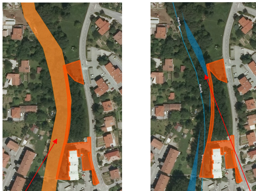
Slika 14: Prikaz mikro lokacije predvidenih posegov v okviru pilotnega projekta ob vodotoku Hubelj v mestu Ajdovščina – Natura 2000 in Vode.
