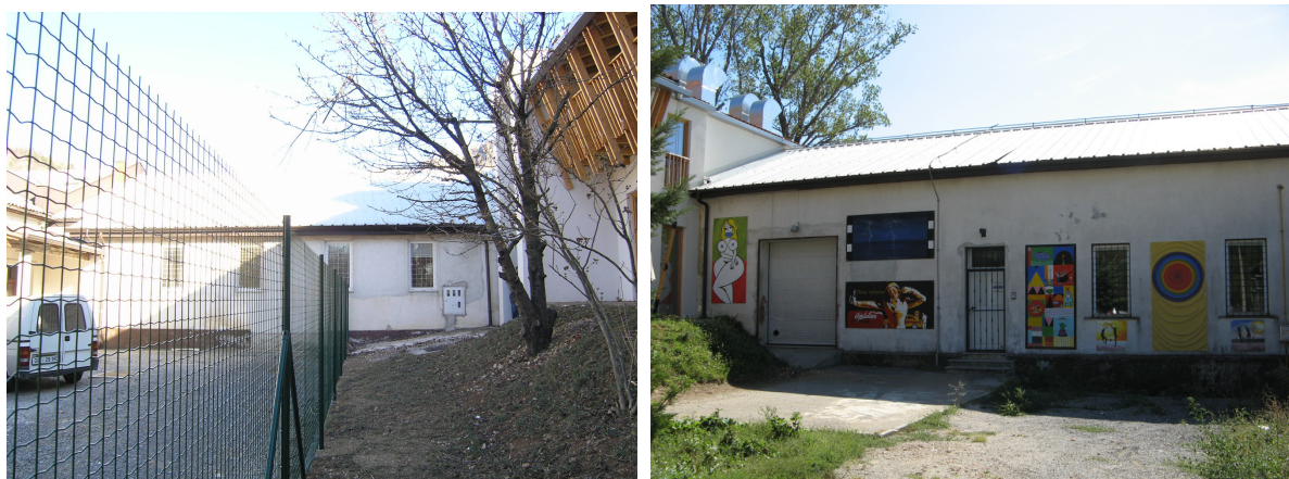
Obstoječi objekt (pogled z južne in severne strani)
