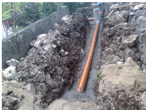
Polaganje kanalizacijskih cevi na Colu
