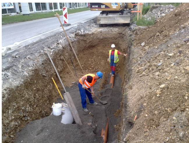
Izgradnja komunalne infrastrukture Goriška cesta - Ajdovščina
