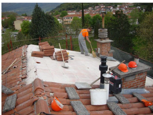
Cesta 18. aprila Vipava – obnova strešne kritine
