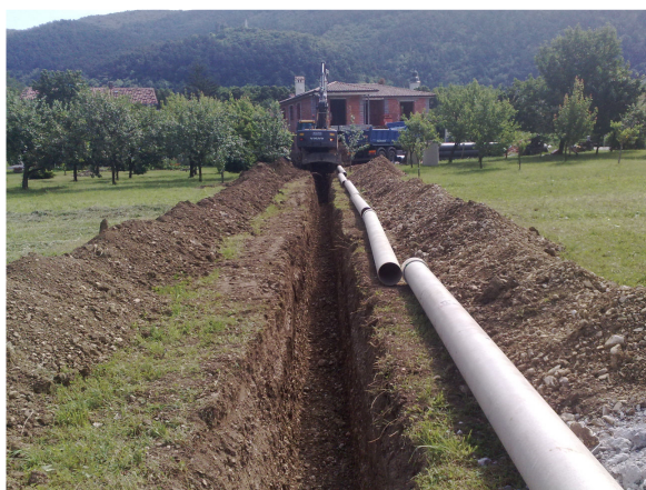
Izgradnja kanalizacije NA PRODU v Vipavi
