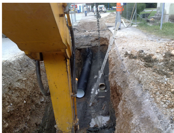
Izgradnja kanalizacije Vojkova ulica v Vipavi
