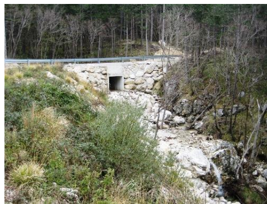
Slika 5 Škatlast prepust na prečkanju potoka Lokavšček
