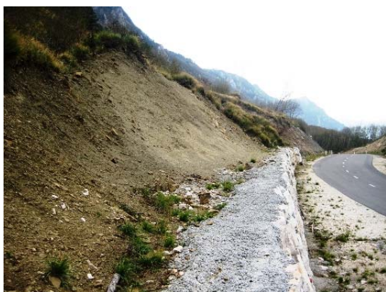
Slika 7 Brežine nad kamnitimi zložbami
