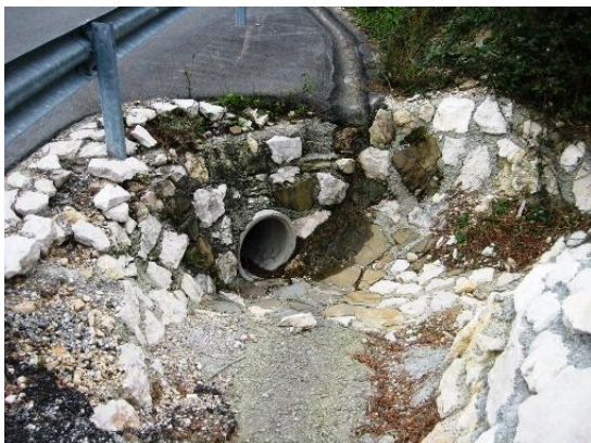
Slika 6 Vtok v prepust
