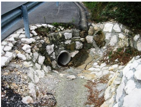
Slika 6 Vtok v prepust
