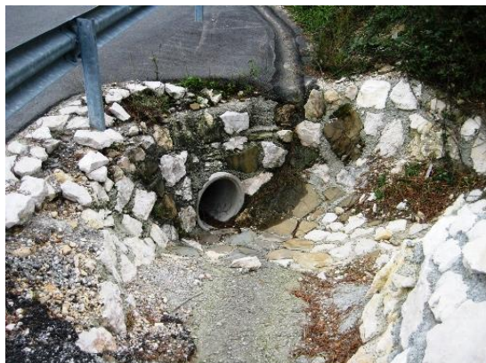
Slika 6 Vtok v prepust
