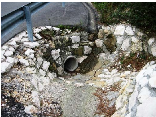
Slika 6 Vtok v prepust
