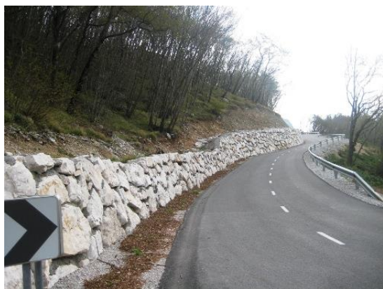
Slika 4 Kamnita zložba od km 6+212 do km6+323
