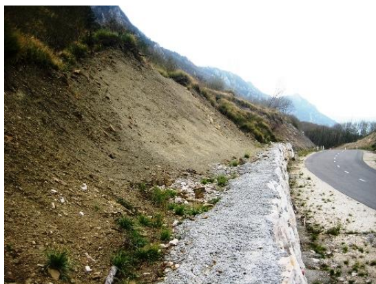
Slika 7 Brežine nad kamnitimi zložbami
