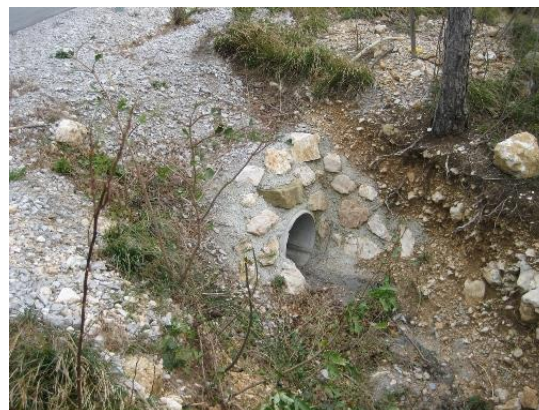
Slika 3 Iztok iz cevne prepusta DN600
