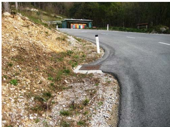
Slika 2 Asfaltna mulda širine 50cm ob vozišču in iztok v jašek pred prepustom
