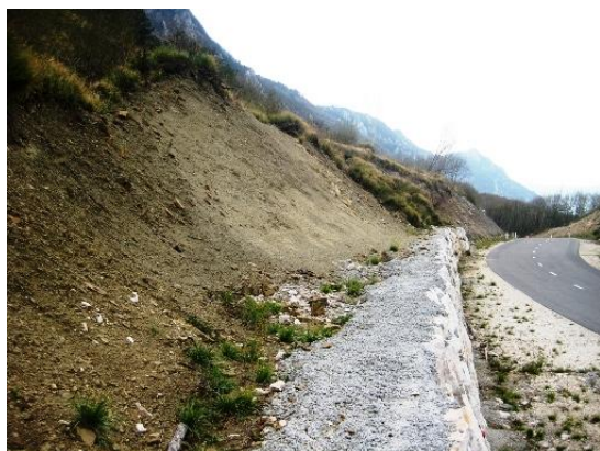
Slika 7 Brežine nad kamnitimi zložbami
