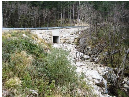
Slika 5 Škatlast prepust na prečkanju potoka Lokavšček
