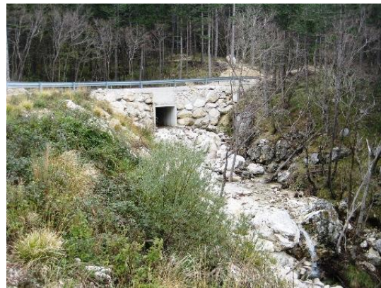
Slika 5 Škatlast prepust na prečkanju potoka Lokavšček
