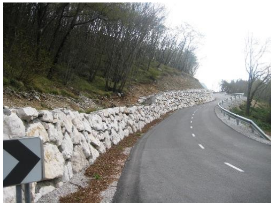
Slika 4 Kamnita zložba od km 6+212 do km6+323
