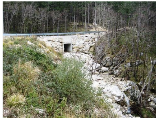
Slika 5 Škatlast prepust na prečkanju potoka Lokavšček
