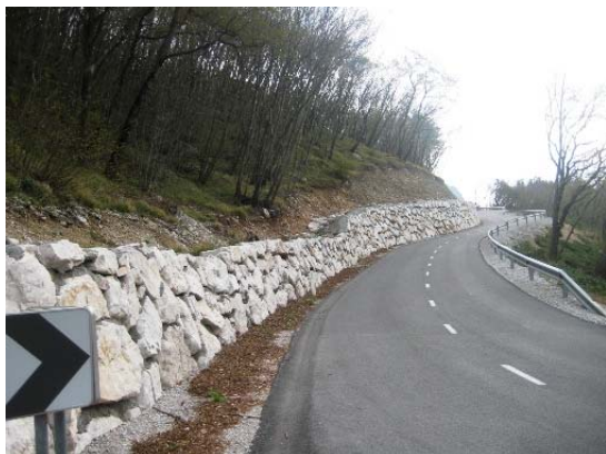
Slika 4 Kamnita zložba od km 6+212 do km6+323
