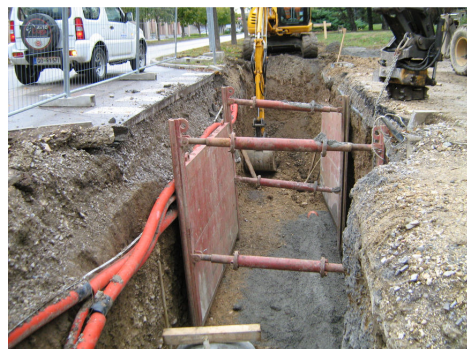
Izgradnja kanalizacije in vodovoda na Goriški cesti v Ajdovščini
