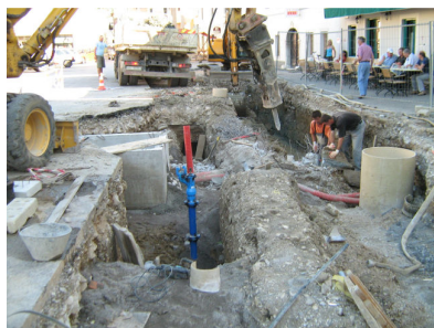
Izgradnja kanalizacije in vodovoda na Glavnem trgu v Vipavi
