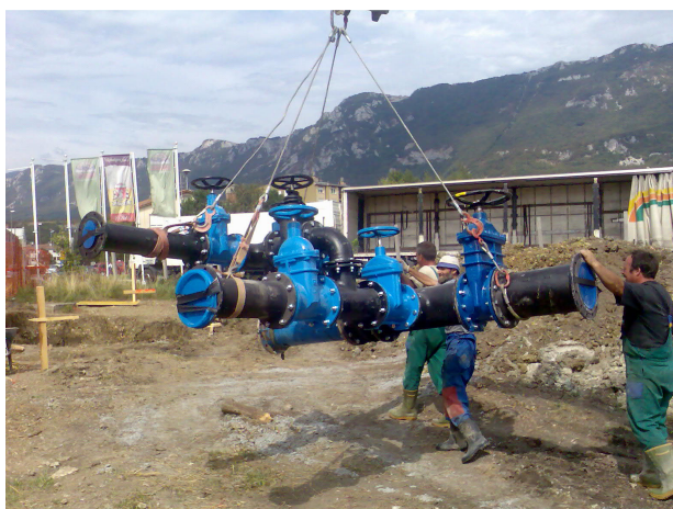
Prenos armatur vodovodnega jaška na projektirano mesto.
