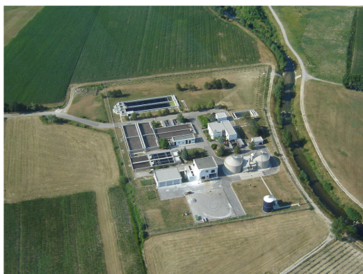
Centralna čistilna naprava Ajdovščina.
