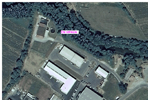
Čistilna naprava Vipava
