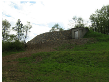
Dograjeni vodohran »KOBOLI«
