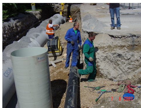
Izgradnja kanalizacije in vodovoda ulica 5. maja v Ajdovščini.
