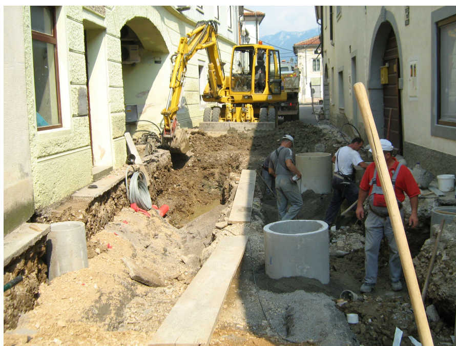
Izgradnja kanalizacije in vodovoda v Vipavi (ulica Vojana Reharja).
