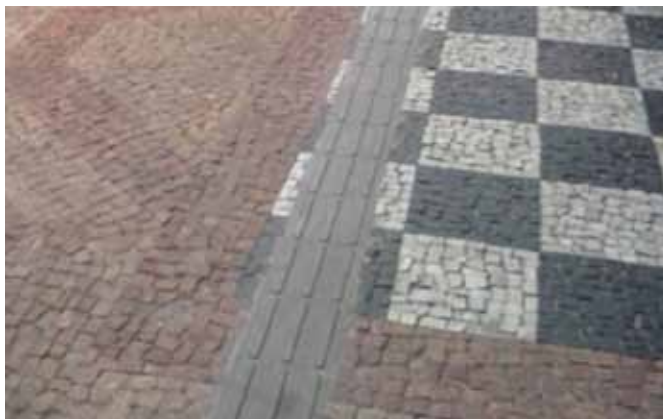
SLIKA 44 Slabo vidna taktilna oznaka
