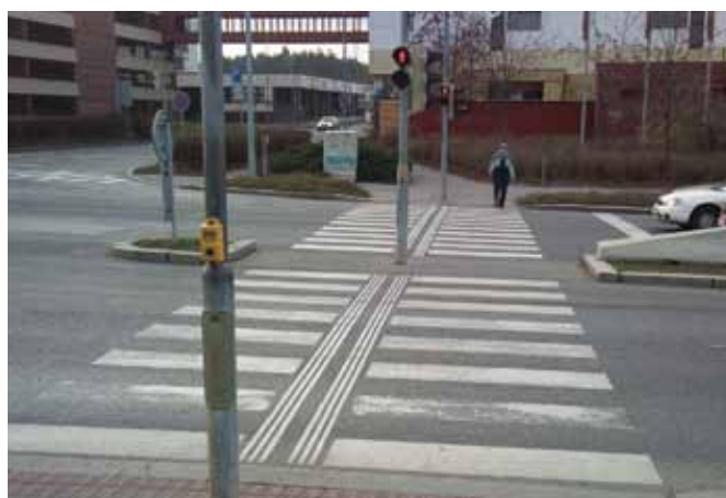
SLIKA 64 Primer vodilne linije čez vozišče
