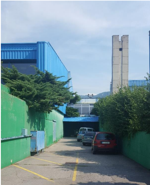
Slika A: Predlog dostopa do dvigala, ki bo omogočalo dostop do vsebin v objektu. Pot je potrebno urediti tako, da bo varna in privlačna za pešce – s poti je potrebno odstraniti smetnjake in ukiniti parkirišča.
