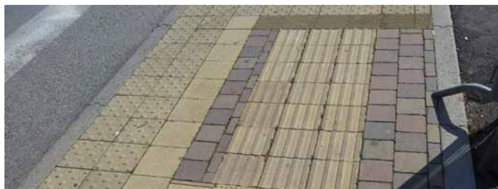
SLIKA 58 Premajhna polja in preveč različnih struktur na majhnem prostoru
