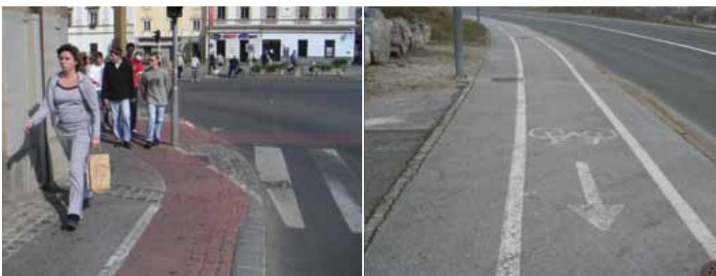
SLIKA 78 Primera neustrezne označitve kolesarske steze in postavitve kolesarske steze sredi pločnika
