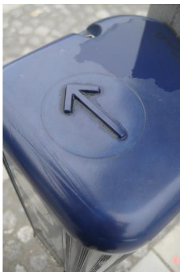
Slika A: Ustrezno opremljen zvočni semafor. Slika B: reliefna puščica na vrhu škatlice semaforja slepi osebi sporoči smer v kateri lahko prečca cesto. Slika C: Na navpični stranici škatlice semaforja lahko slepi otipa postavitev prometnih pasov in dobi občutek o velikosti ceste, ki jo namerava prečkati.
