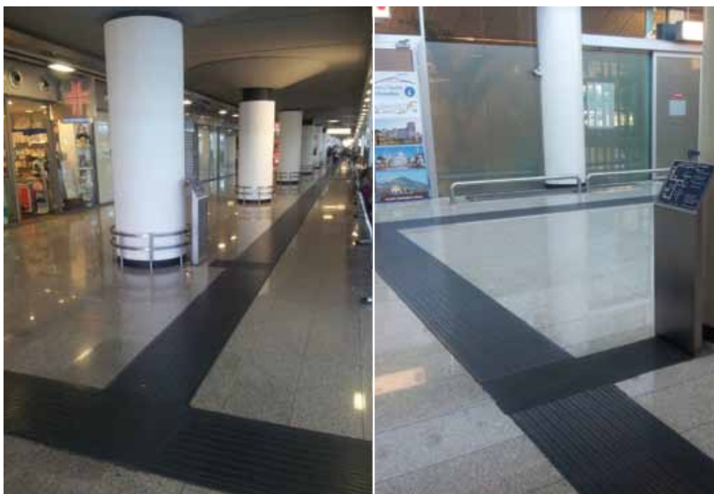
SLIKA 74 Primer kompleksnega vodenja po letališču
