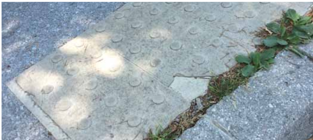
SLIKA 30 Slaba vzdržljivost lepljenih oznak iz umetnih mas v odprtem prostoru
