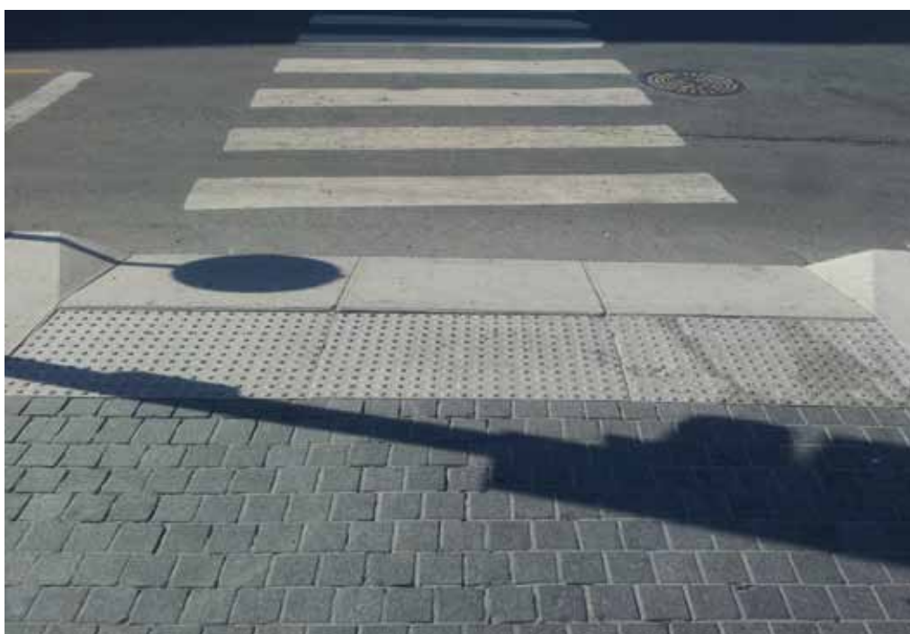
SLIKA 68 Primer označitve roba vozišča na prehodu za pešce
