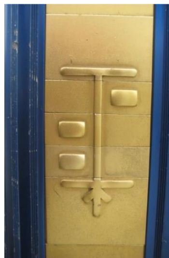
Slika A: Ustrezno opremljen zvočni semafor. Slika B: reliefna puščica na vrhu škatlice semaforja slepi osebi sporoči smer v kateri lahko prečca cesto. Slika C: Na navpični stranici škatlice semaforja lahko slepi otipa postavitev prometnih pasov in dobi občutek o velikosti ceste, ki jo namerava prečkati.
