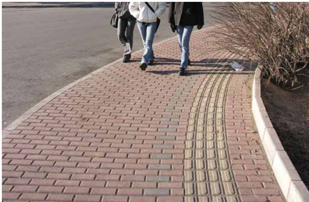
SLIKA 84 Odvečna vodilna linija ob robu
