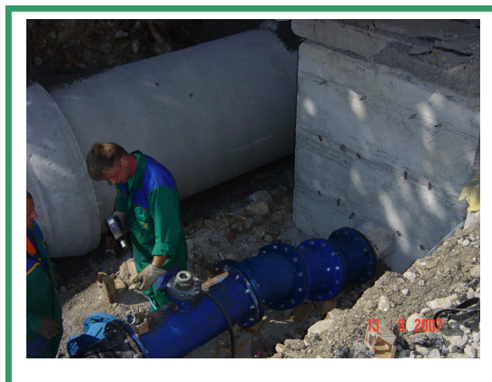
Obnova vodovoda in kanalizacije v mestu Ajdovščina
