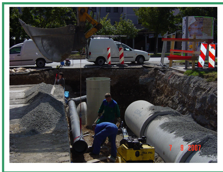
Obnova vodovoda in kanalizacije v mestu Ajdovščina
