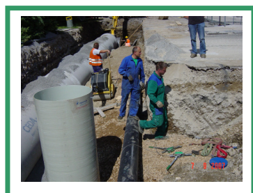
Zamenjava vodovodnih in kanalizacijski cevi v mestu Ajdovščina
