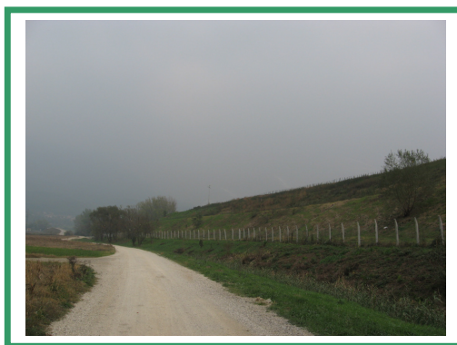
Urejena in zasajena brežina odlagališča odpadkov Dolga poljana
