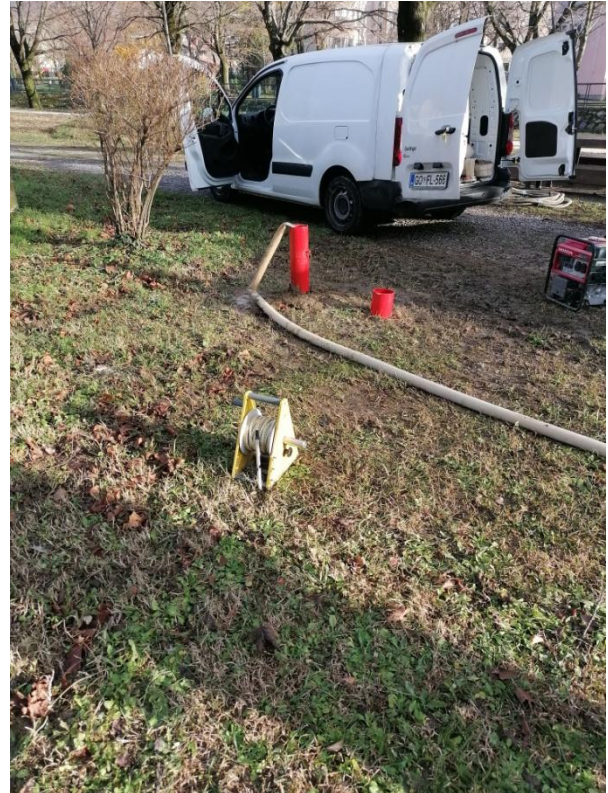
Slika 18: Izvedba ponikalnega poskusa v vrtini V-2
