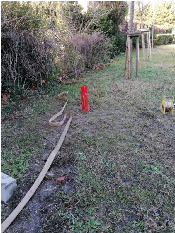
Slika 19: Izvedba ponikalnega poskusa v vrtini V-3
