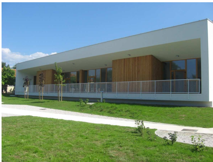
Slika 4: Zunanost objekta vrtec Ribnik 2
