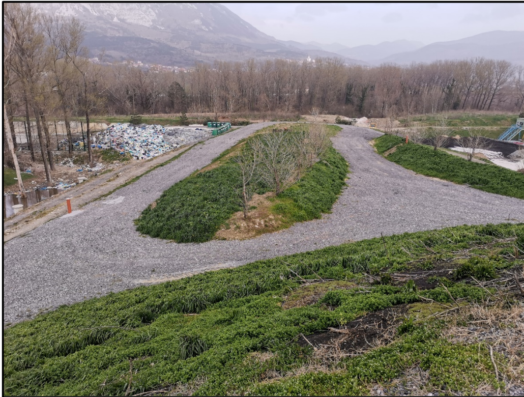
Slika 3: Pogled na dokončano vrhno teraso 3. sektorja odlagališča z roba vrhnje terase 2. sektorja odlagališča. Levo zgoraj kup mešane komunalne embalaže, ki v letu 2019 ni bila prevzeta s strani DROE. Navpično vgrajena oranžna cev na levi predstavlja enega izmed ~15 reperjev namenjenih meritvam posedkov odlagališča.
