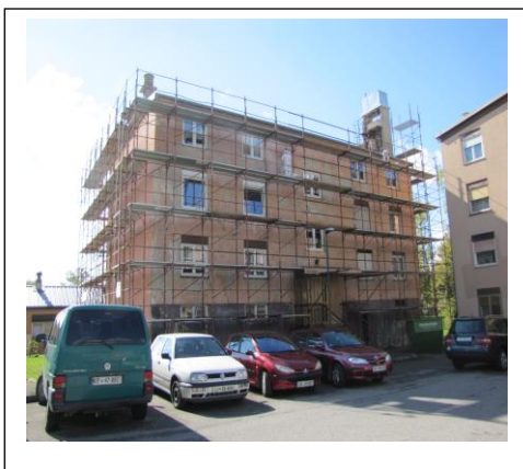
Ob Hublju 2- začetek sanacije fasade
