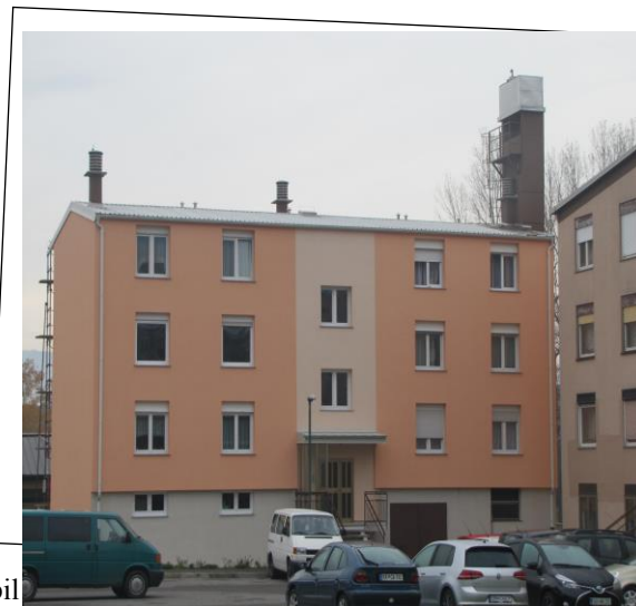
Ob Hublju 2- po končani sanaciji
