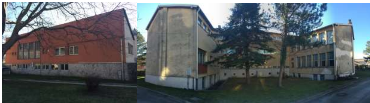
Slika 3: OŠ Danilo LOKAR – stavba1: severna in vzhodna fasada
