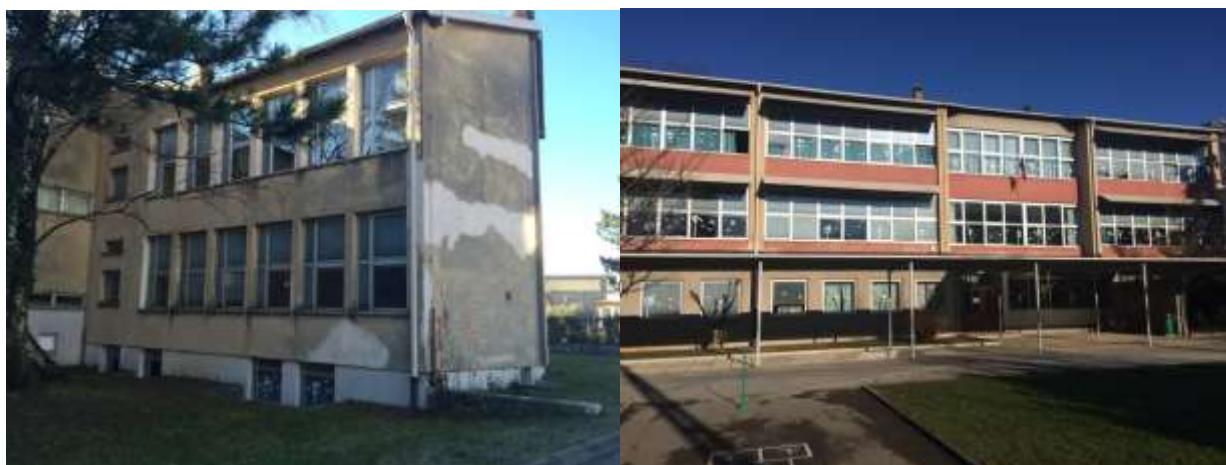
Slika 4: Zahodni krak in južna fasada objekta S2
