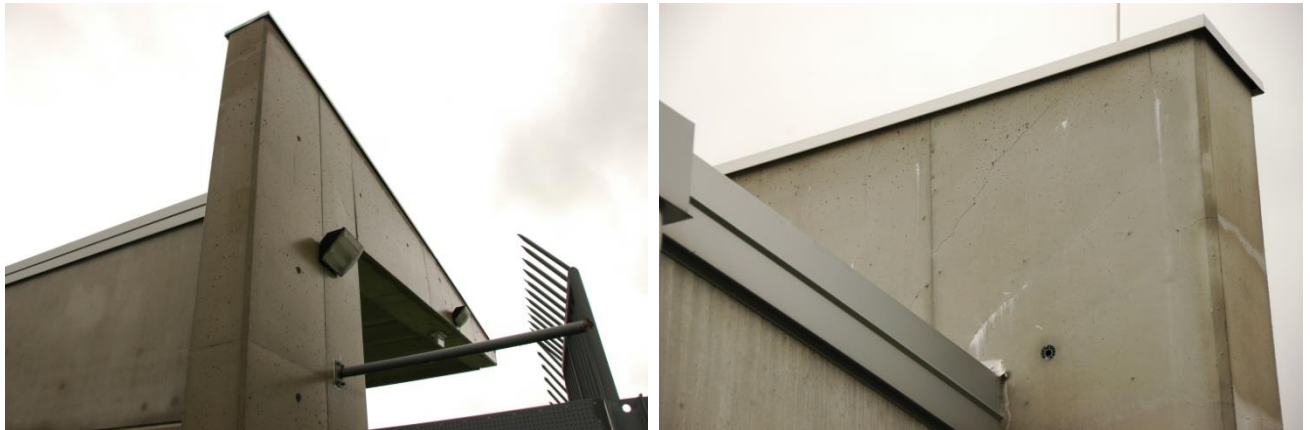
Slika 2: pogled na robni in vmesni steber konstrukcije
