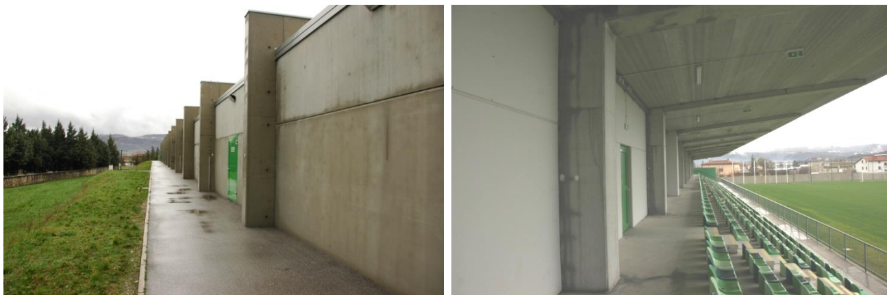
Slika 1: pogled na nosilno konstrukcijo nadstrešnice - pogled proti jugu na vzhodni in zahodni strani
