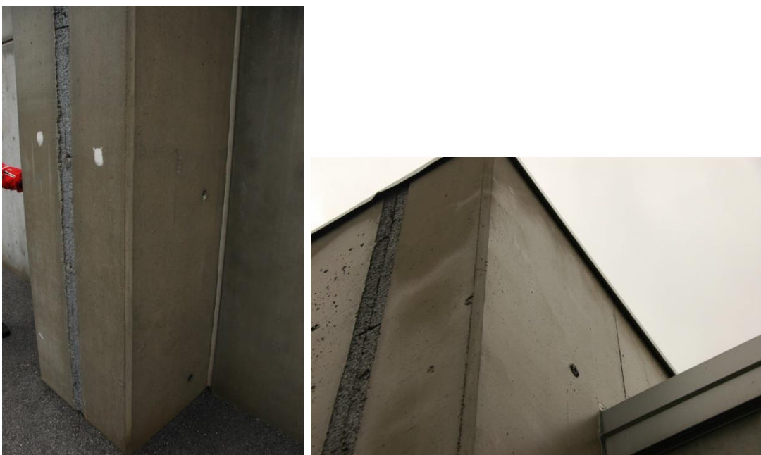
Slika 7: detajl stebrov ob dilataciji
