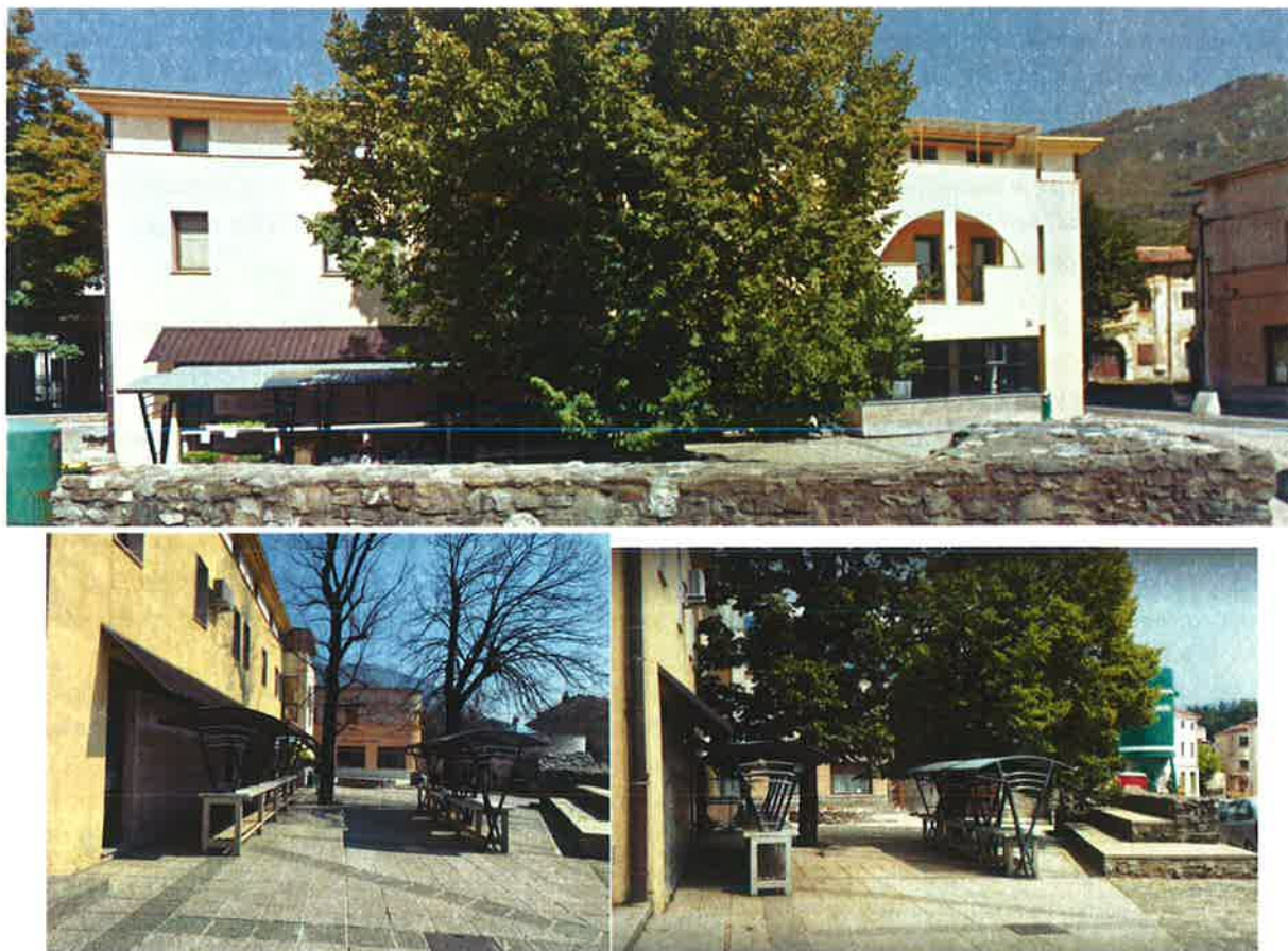
Slika 2: Obstoječa stavba mestne tržnice.
