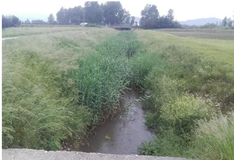
Slika 4: Pogled na strugo Kožmanskega potoka dolvodno od sotočja z odvodnikom A
